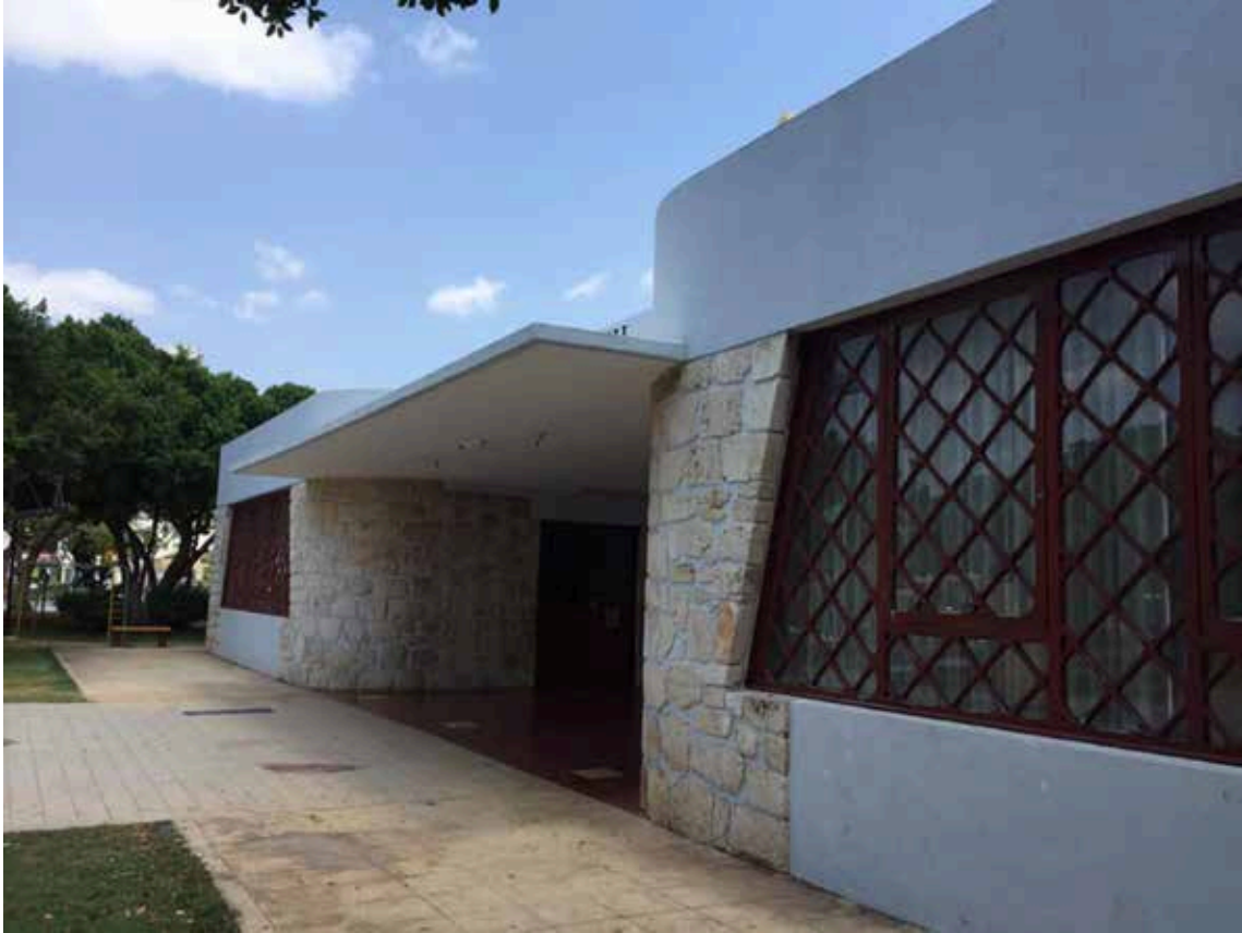
Figura 3. Vista del Jardín de niños Felipe Carillo Puerto, en la colonia García Ginerés, en la avenida Colón en Mérida Yucatán, fotografía 2018. Ejemplo del sentido heterogéneo de la voluntad de la forma, que nos hace cuestionarnos qué entendemos por las arquitecturas neoprehispánica, art déco y funcionalista. Fuente: Colección del autor.
