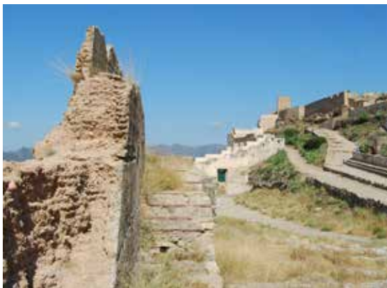
Figura 6. Las murallas medievales de Sagunto, España, se realizaron con la técnica llamada “tapia calicostrada” en la que se emplea tierra compactada con hidróxido de calcio. (Foto: L. Guerrero).
