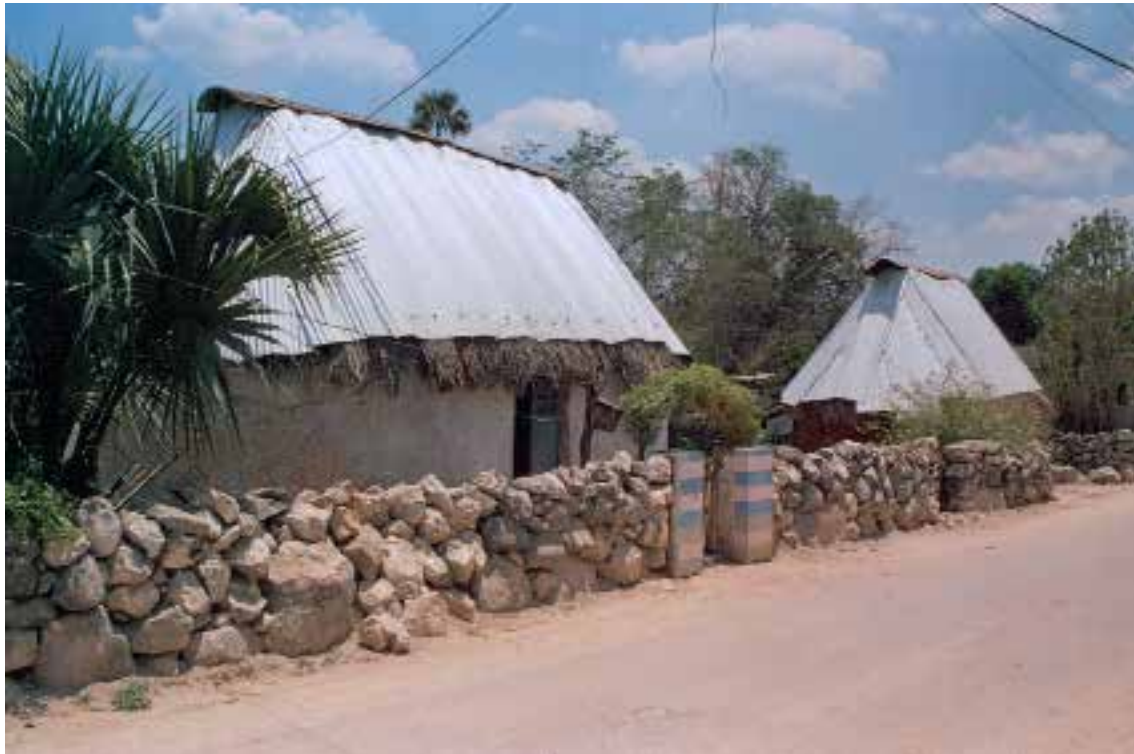
Fig. 5. Viviendas vernáculas con láminas de zinc cubriendo el techo de palma. Nunkiní, Campeche Fuente: Tomada por el autor, 2002
